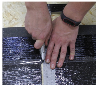
Рис. 77. Деление плитки на лепестки
