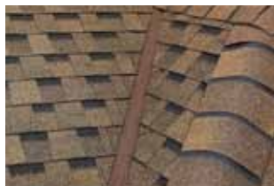
Калифорнийская ендова (один из вариантов открытого способа)
