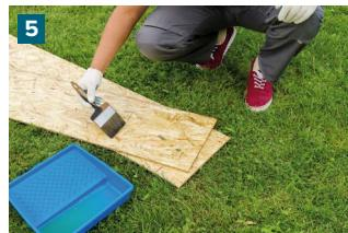
Перед установкой сплошного настила обработайте плиты (доски) полимерной либо битумной обмазочной гидроизоляцией на высоту не менее 300 мм от уровня отмостки.
