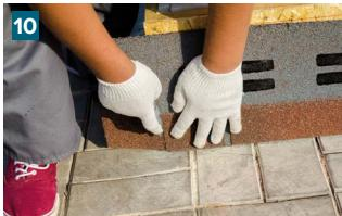
Рядовую плитку, выходящую на внешний угол, подрежьте так, чтобы расстояние от ее края до грани угла было 5–10 мм.
