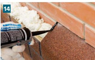
Монтаж планок проведите с нахлестом 3-5 см. Место стыка двух планок промажьте герметиком.
