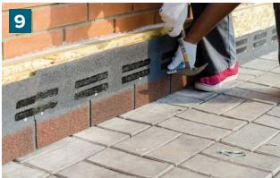
Каждую плитку прикрепите на 8 гвоздей так, чтобы нахлест вышележащей плитки перекрывал гвозди нижележащей. При перепаде высот проведите измерение от нижней части цоколя.
