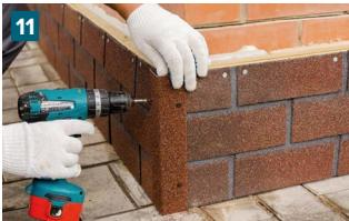
Уголки установите снизу вверх с нахлестом ~5 см и прикрепите с двух сторон специальными оцинкованными саморезами с шагом 300 мм.
