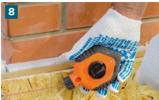
Отметьте точку на высоту одной плитки от уровня отмостки и отмерьте расстояние от верхней части цоколя до этой точки. Отмерьте это же расстояние на другом конце цоколя и соедините точки в направляющую линию с помощью шнурки-отбивки.
