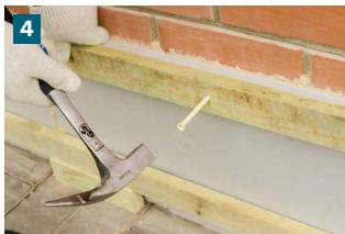
Для устройства обрешетки используйте бруски сечением 20\*40 мм. Расстояние между брусками горизонтальной обрешетки должно составлять не более 300 мм. Крепление - дюбель минимум 120 мм.
