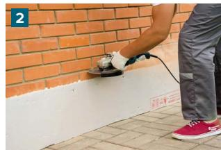
Для монтажа цокольной планки, в стене, выше цоколя на 2-5 см, прорежьте штробу для герметичной установки планки. Глубина пропила - 1 см.
